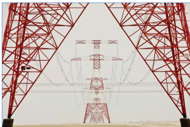
Hochspannungsleitung mit dämpfenden Feldabstandhaltern
